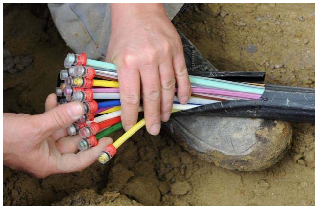
Ein Glasfaserkabel besteht aus farbigen Einzelsträngen. Erst diese machen das schnelle Internet technisch möglich. (Foto: Archiv/dpa)
